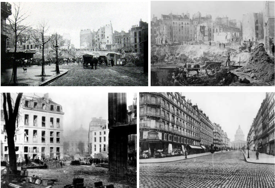
Derribos (1858), dos imágenes de la construcción de la Avenida de la Ópera (1858) y la Rue Soufflot con el Panteón al fondo (1858). Fotografías de Charles Marville (1816-1879).
